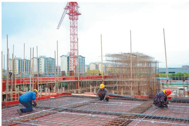
近日,预制菜生产基地及配套设施建设项目(一期)施工现场,工人们在绑扎钢筋。
