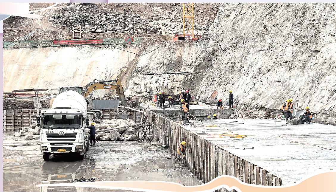
11月6日,梁平中心水库施工现场,工人们在对大坝坝体进行清仓、凿毛。
