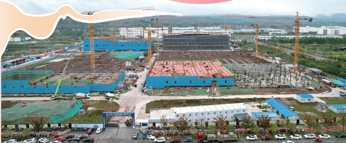
11月19日,中铁十五局西南公司承建的梁平冷链物流园建设项目(三期)在如火如荼地推进。
