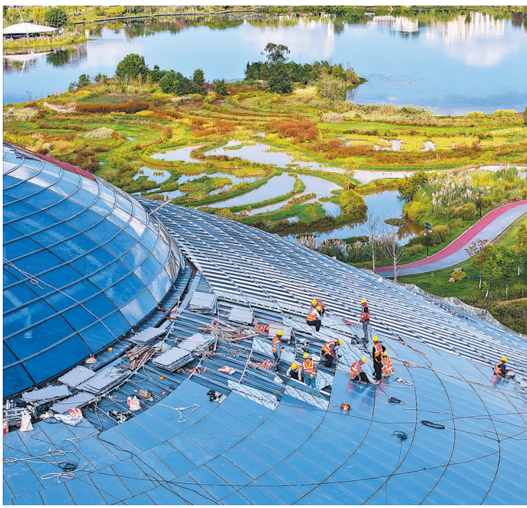
十月二十二日,都梁大剧院项目施工现场,工人正在进行外幕墙安装施工。记者 刘辉 摄
