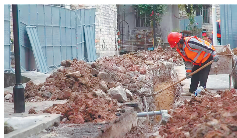
近日,位于双桂城区的双桂佳苑小区,工人正在进行供水管网改造作业。
