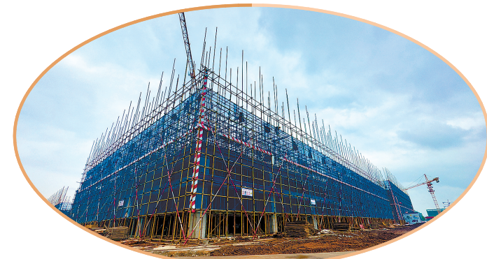
10月12日,梁平高新区集成电路孵化园项目施工现场,项目主体结构初具雏形。
